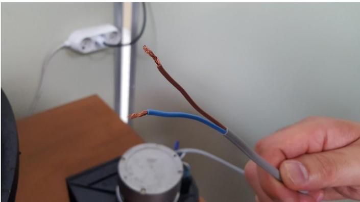
3. 新しい送風機を入れて、同じ位置に装着しねじで固定します。同じ色の電線で連結して絶縁テープで仕上げます。
